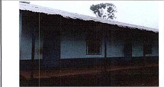
Foto 1: Laminas en mal estado
