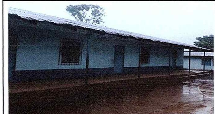
Foto 4: Laminas en mal estado
